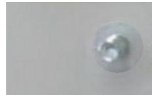
Abb. 20: Nicht gekennzeichnete Erdungsbolzen
